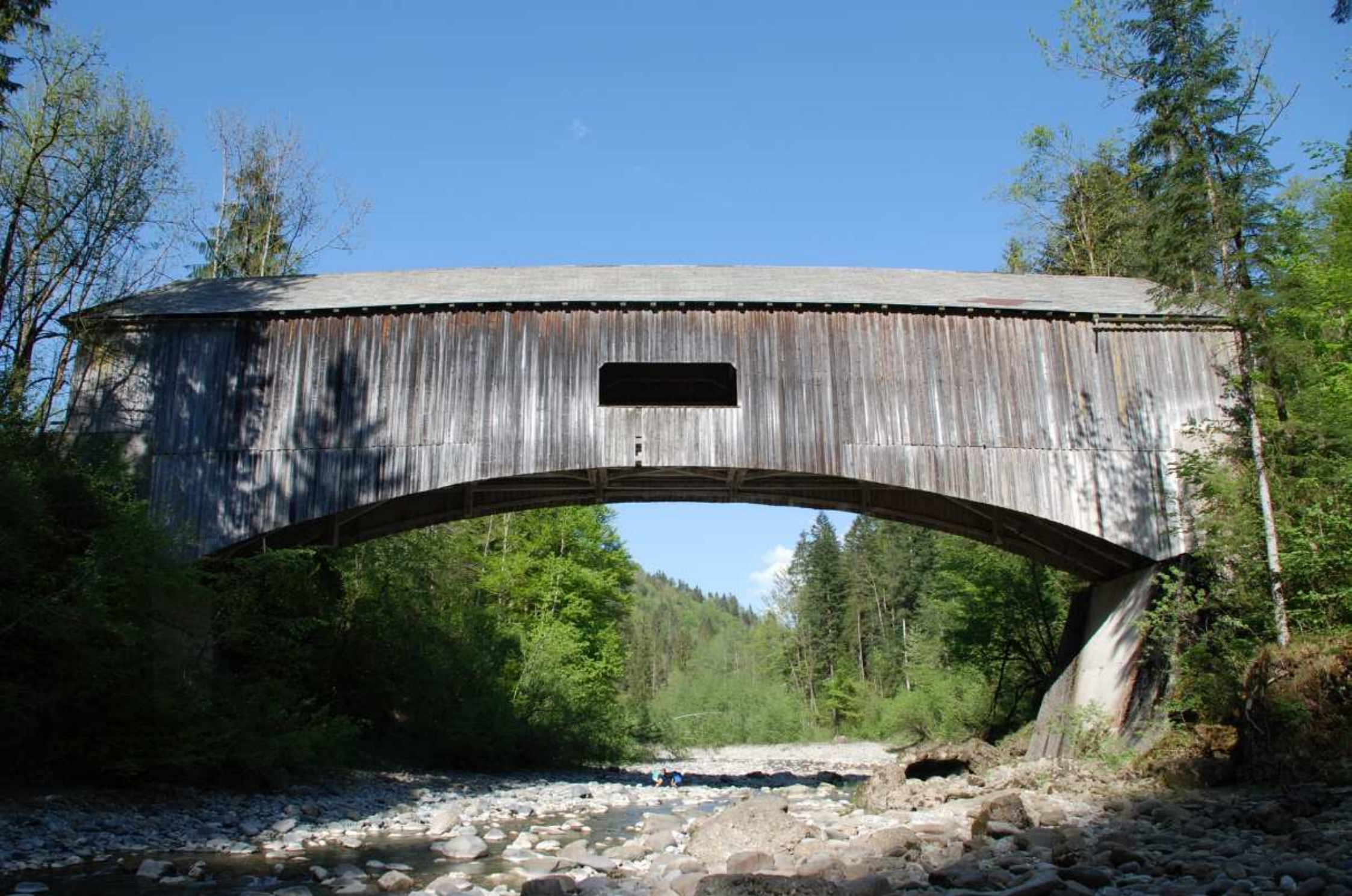
13a. Alte Holzbrücke
