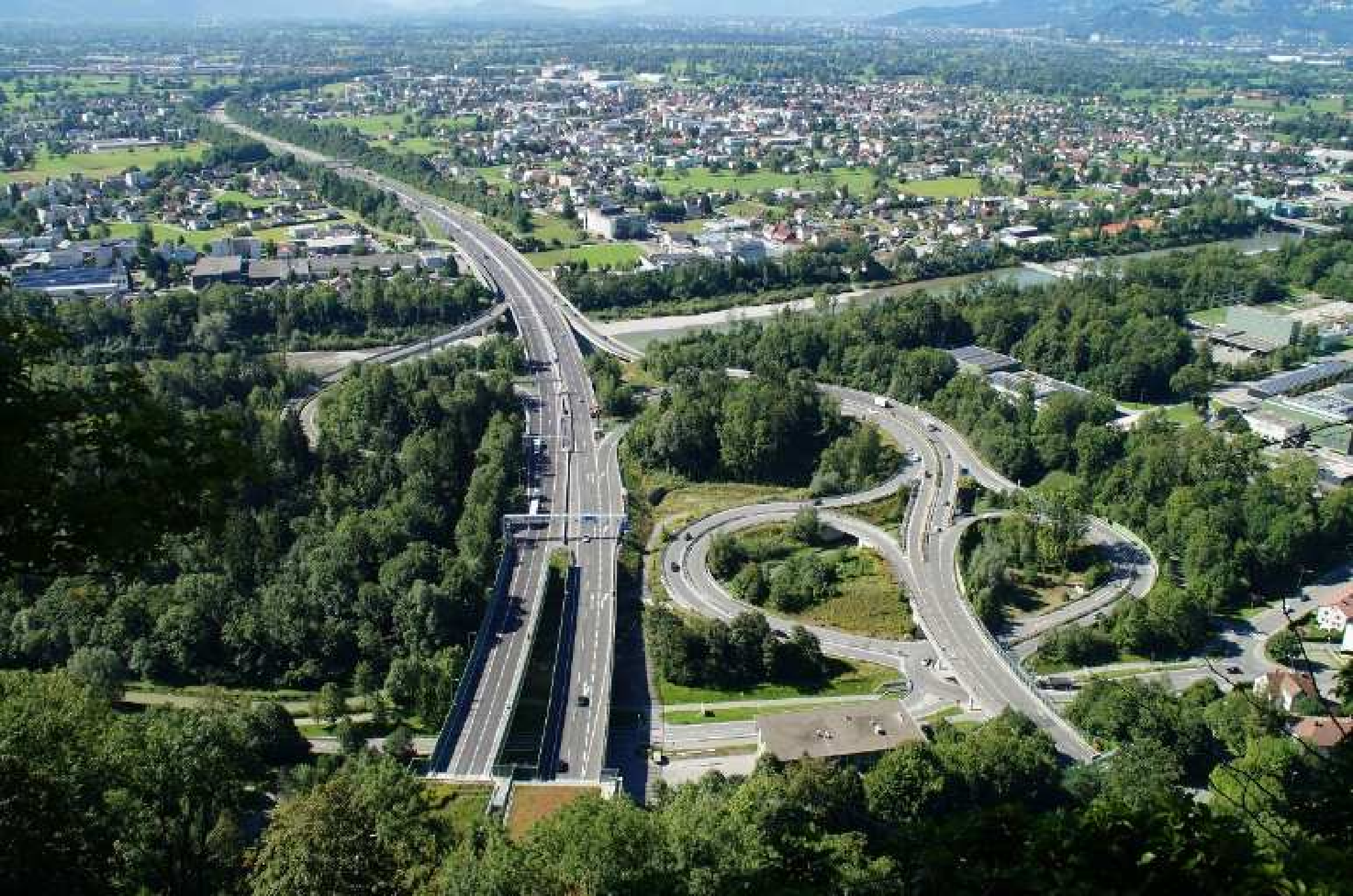
33. Autobahn A14 und Pfändertunnel
